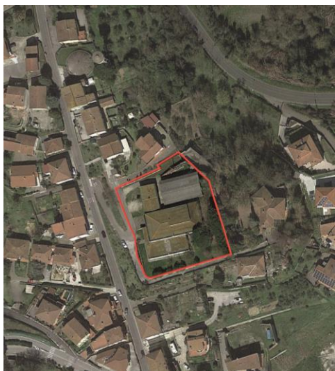
Foto aerea dell'area oggetto di intervento
